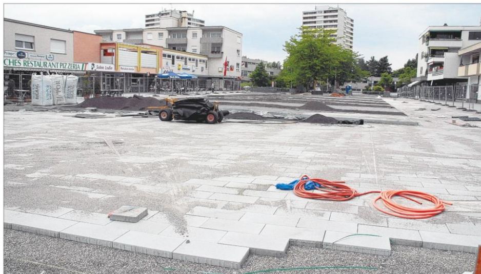
Die Arbeiten am Berliner Platz kommen jetzt zügig voran, Ende Juni werden sie abgeschlossen.
